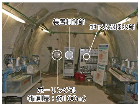
深度300m予備ステージにおける地下水の水質観測装置
